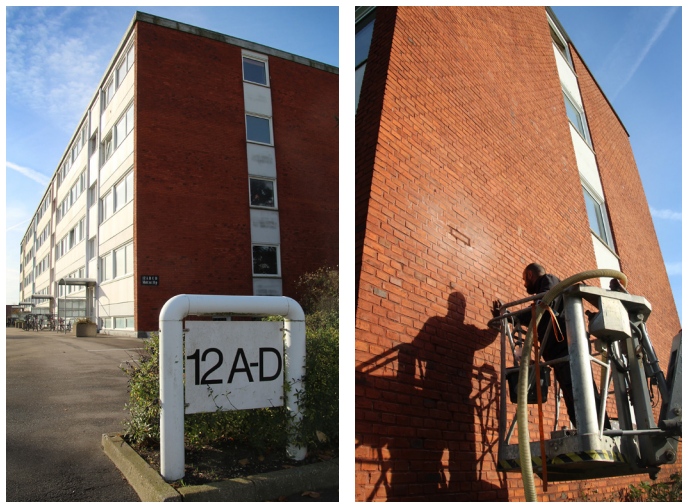
Gyvelvej 12 har fået hulmursisolere sine to gavle
